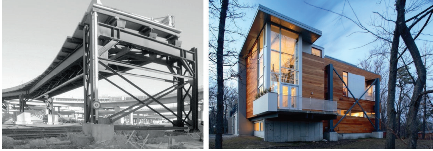
Görsel 3. Otoyol İnşaatında Kullanılan Geçici Rampanın Eve Dönüşümü
