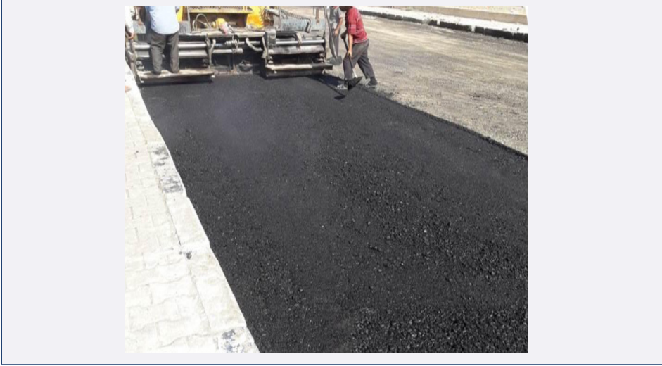
GÖRSEL 2. AZEZ’DE ASFALTAMA ÇALIŞMASI
